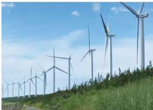
風力発電システム
